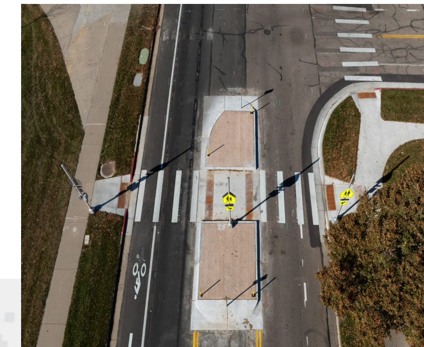
Cruces peatonales con refugio en la mediana
